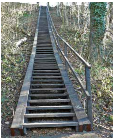
MZD wykonał remont schodów łączących ul. Łowiecką z Parkiem pod Wałką (koszt: 17 160,32 zł).
