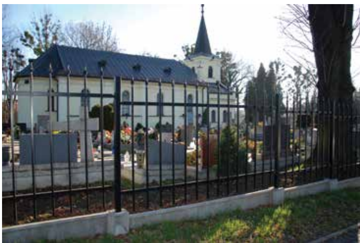
Na cmentarzu komunalnym znajdującym się przy Parafii Imienia Najświętszej Marii Panny w Cieszynie Bobrku trwały prace remontowe, które objęły ogrodzenie z bramami cmentarnymi...
