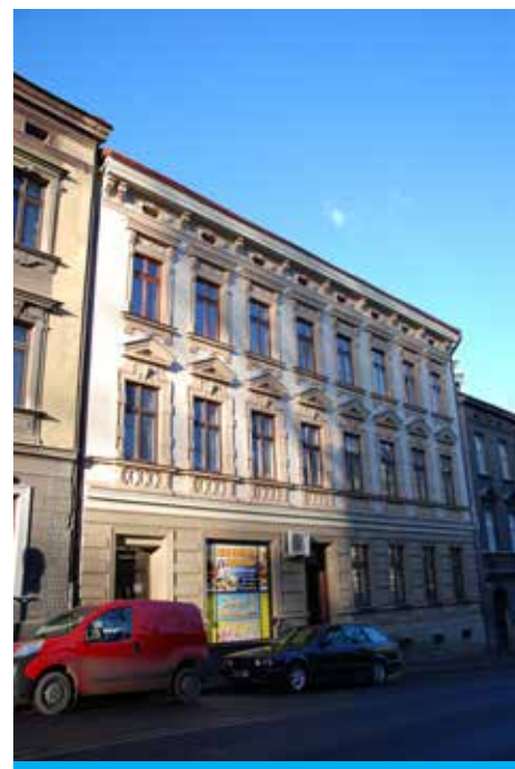
Wyremontowana elewacja frontowa budynku przy ul. Górnej 16.
