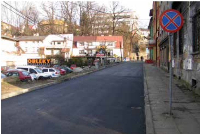
Nowa nawierzchnia na ul. Schodowej...
