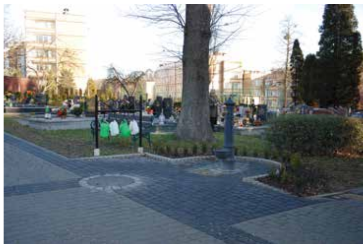
... jak również kanalizację wraz z odnowieniem nawierzchni alejek. Został wykonany także drugi punkt czerpalny wody.
