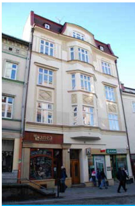
Odnowiona elewacja frontowa kamienicy przy ul. Głębokiej 35.
